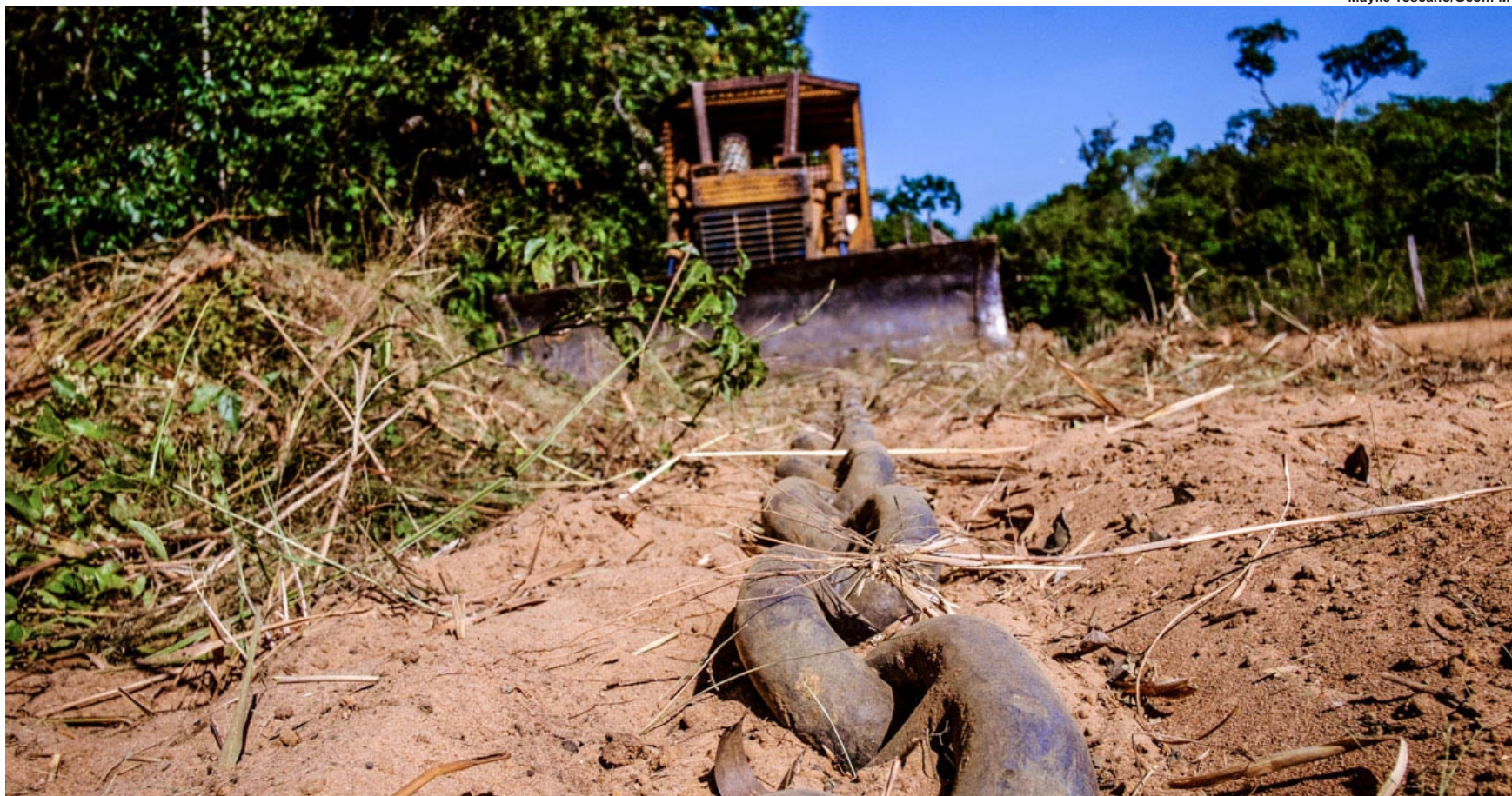
Correntão, técnica que usa dois tratores e uma corrente com elos grossos para derrubar a vegetação nativa
